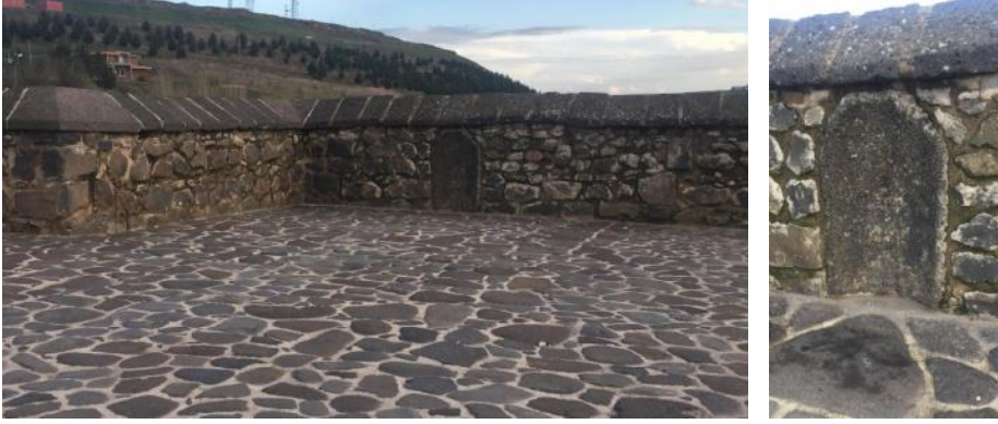
Fotoğraf 14-15: Diyarbakır Dicle (On Gözlü) Köprüsü Namazgâhı
