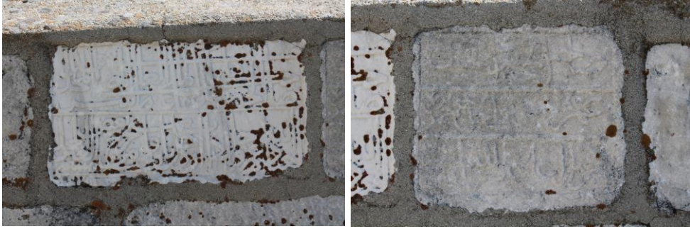
Fotoğraf 11-12: Sivrihisar Musallâsı inşâ ve onarım kitabeleri
