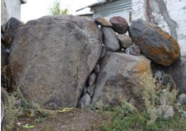
Fotoğraf 7. Baykara Mezarlığının Doğu Yönündeki Mezar Duvarları
