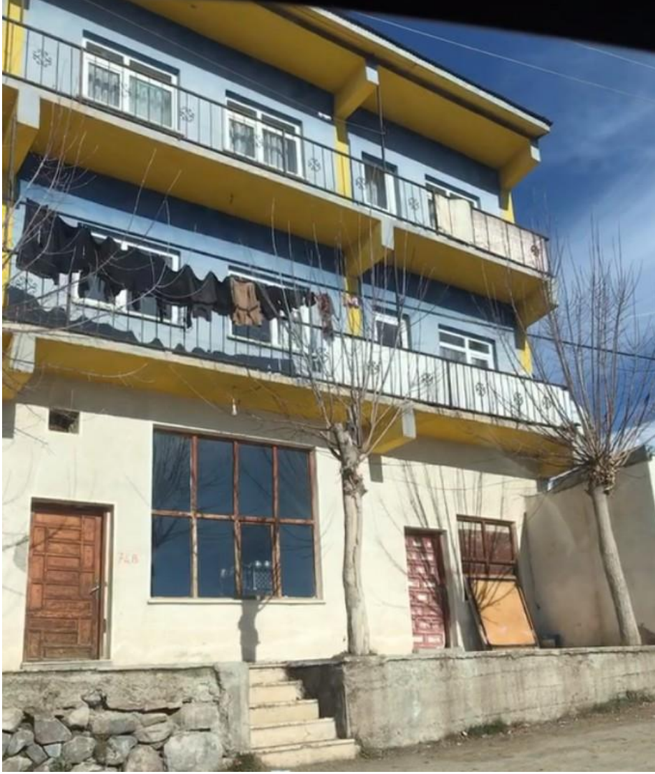
Şekil 3.14 Köy içerisinde apartman tipi yapı örneđi (Yazar arşivi, 2025)
